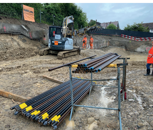
Vorbereitung der KSB-Anker mit speziell gefertigten Hüllrohre für die freie Ankerlänge mittels chargengeprüftem System.
