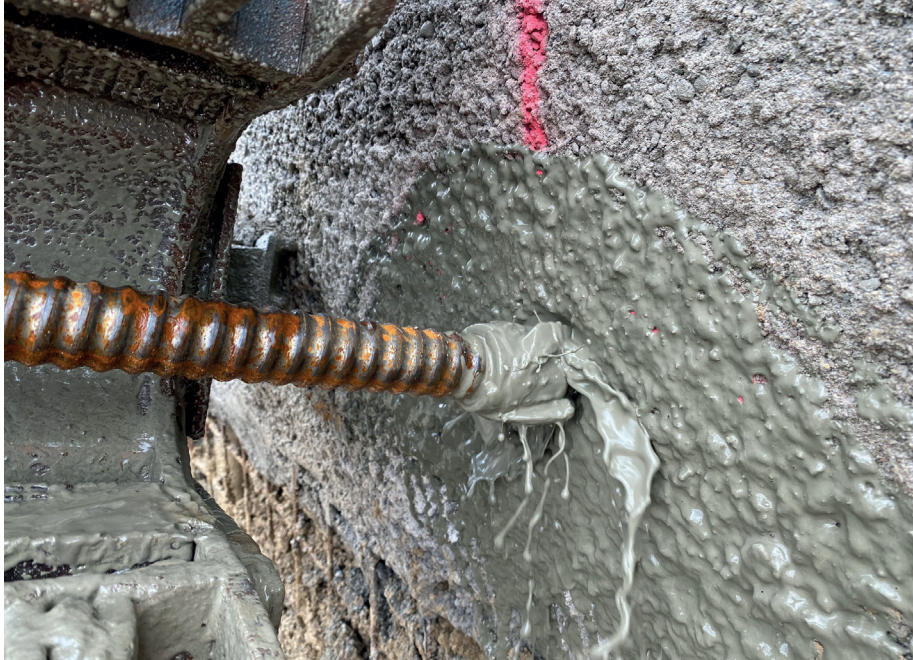
Direktbohren mittels Kümix-Spülung (Zementsuspension), dadurch keine Destabilisierung des Baugrunds durch Wasser oder Luftspülung.
