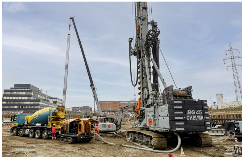
Am Grossdrehbohrgeräte Bauer BG 45 ist eine Betonpumpe (links im Bild) angeschlossen, über die kontinuierlich das Bohrloch von unten her verfüllt wird, sobald die Bohrschnecke ausfährt.
