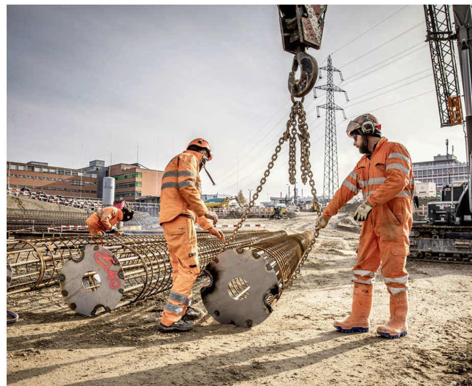
Die riesigen Armierungskörbe werden aus Einzelteilen direkt auf der Baustelle zusammengeschnitten. Sie sind bis 30 Meter lang und wiegen jeder rund drei Tonnen.
