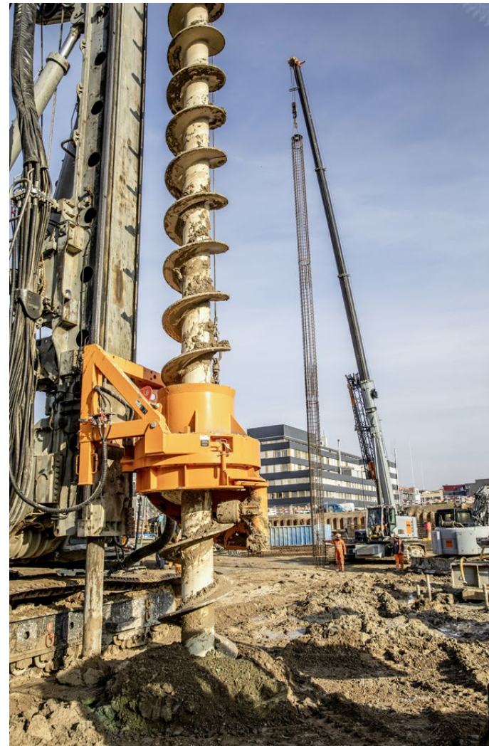
Nachdem die korrekte Ausführung der Bohrung kontrolliert wurde, kann die Bewehrung eingesetzt werden.
