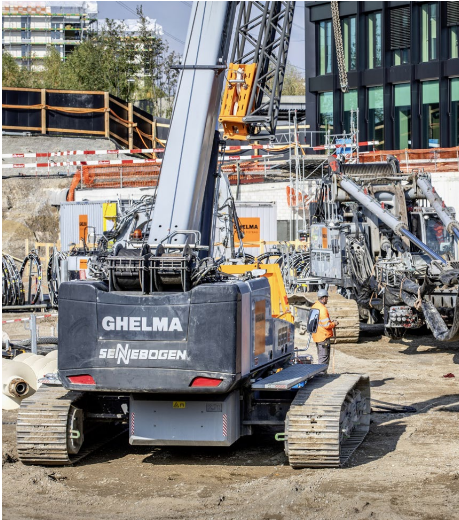
Die Arbeiten waren vor Weihnachten planmässig beendet, alle 200 Bohrpfähle sind gesetzt. In kurzer Zeit wird das schwere Bohrgerät demontiert. Der nächste Einsatz ist bereits geplant.
