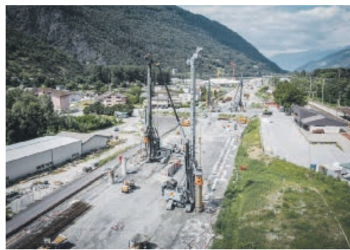
Herausforderung. Die Baustelle ist gleich neben dem Bahnhof angesiedelt.
