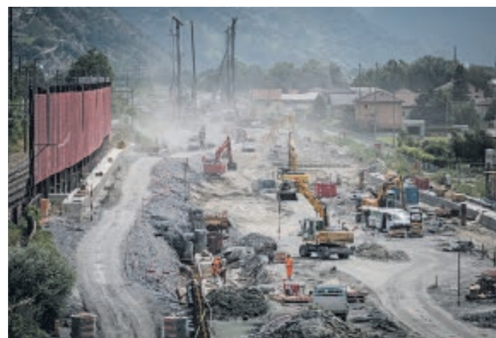
Staubig. Eine Grossbaustelle lässt sich nicht ohne Emissionen betreiben.
