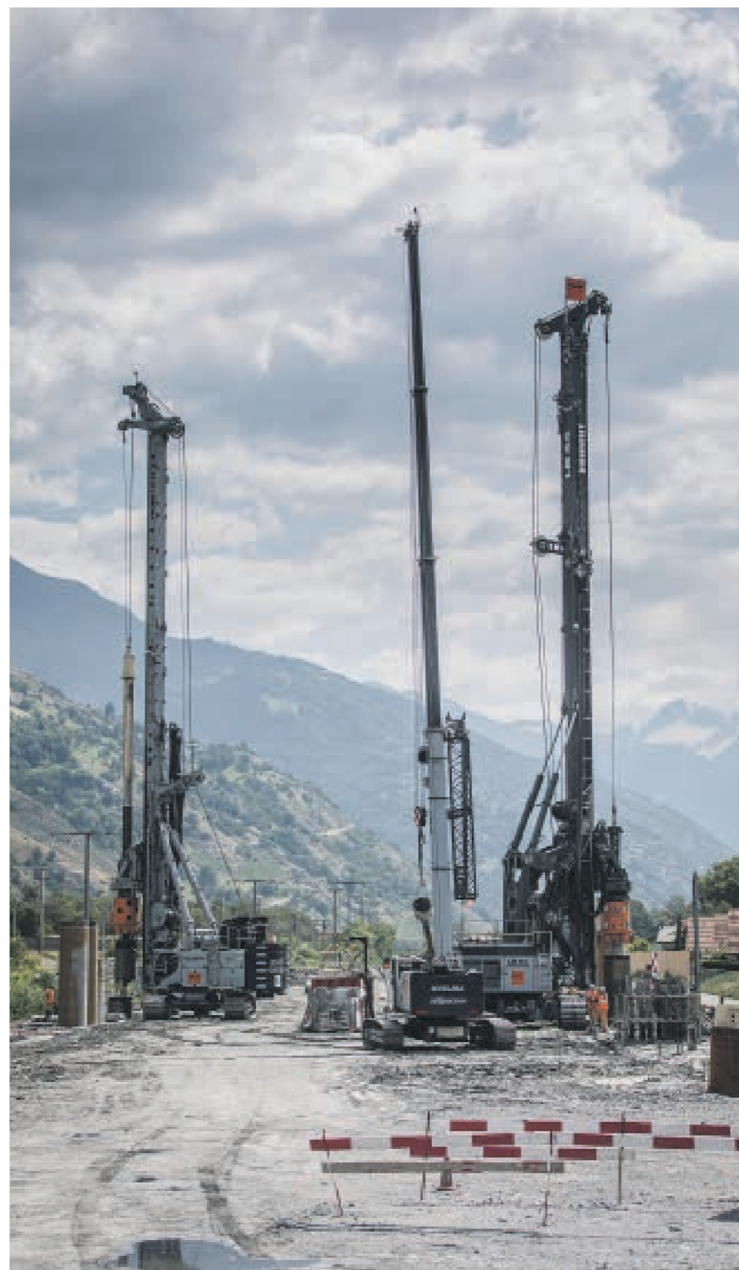
In den Himmel. Die Bohrtürme ragen satte 30 Meter in die Luft.
