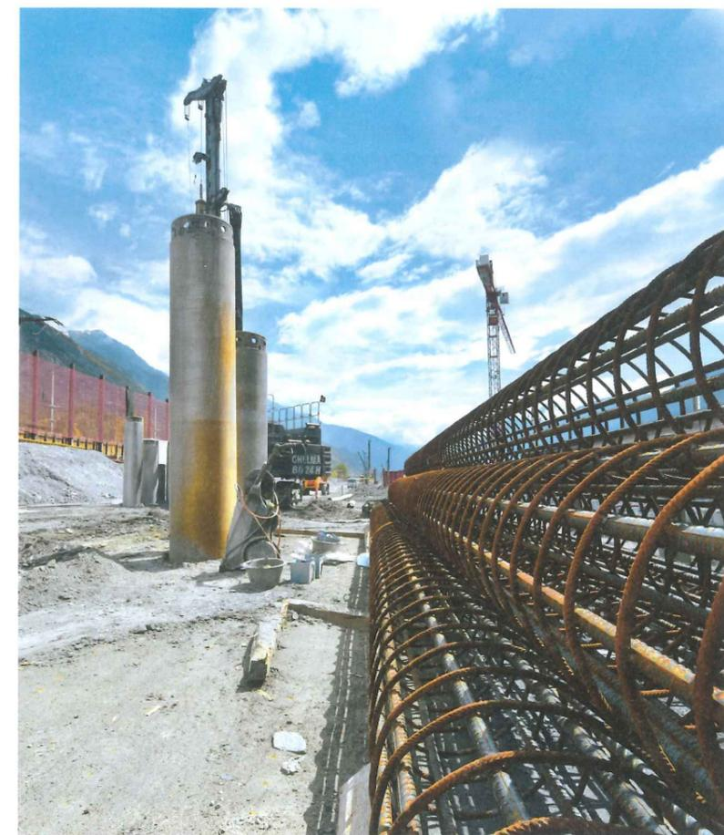
2'400 Bohrfähle werden hier gebohrt, und die Armierung für die Sekundärpfähle liegt bereit.
