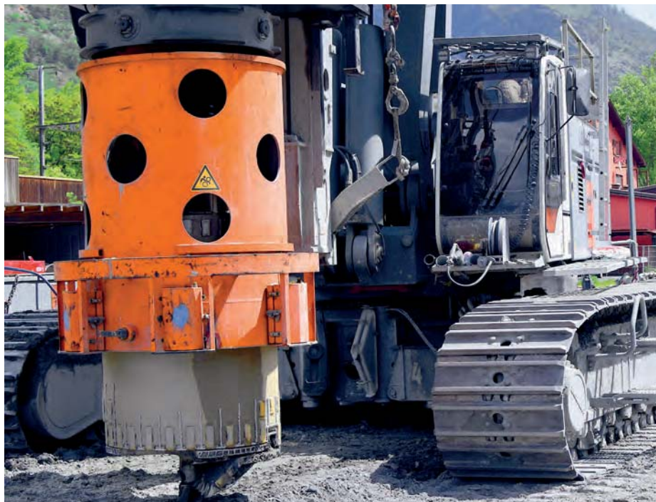
Kriechende Kolosse: Die 150tönnigen Bohrgeräte.
