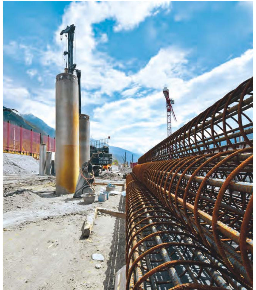
2'400 Bohrpfähle werden hier gebohrt, und die Armierung für die Sekundärpfähle liegt bereit.
