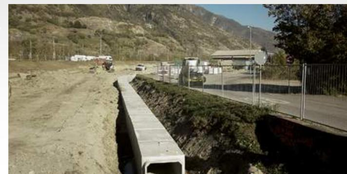
Versetzte Betonelemente zur Aufnahme des Nordkanals.
