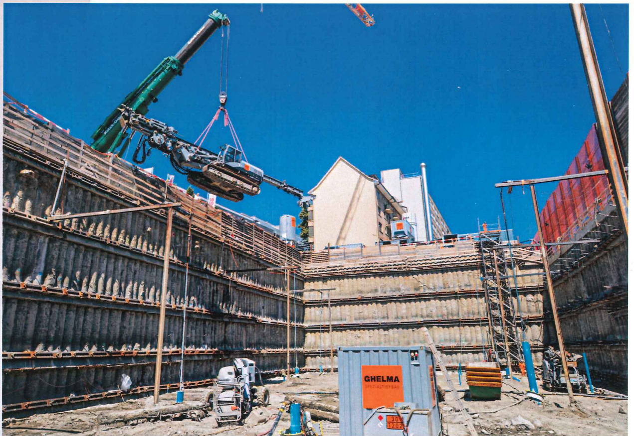
BG 20 #2255, Dichtwand-Baustelle, Bern, Schweiz
