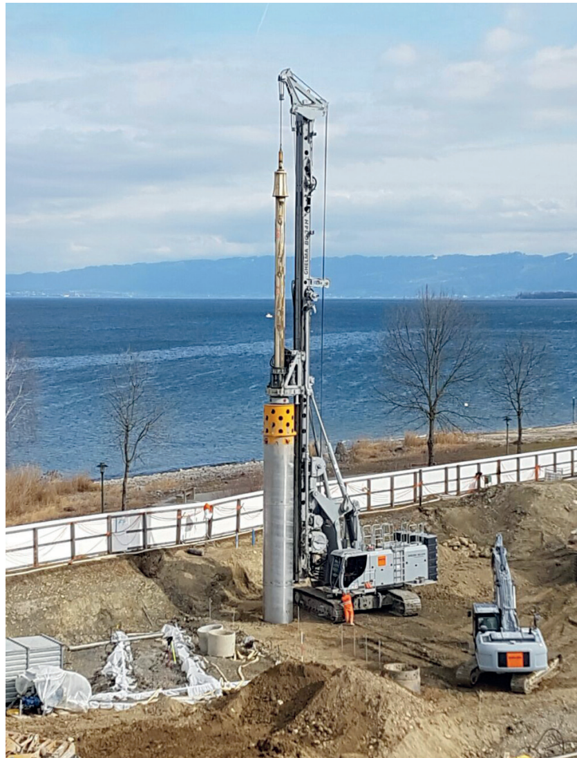
BG 34 H, Bodenaustauschbohrungen in Horn/ Bodensee, Schweiz
