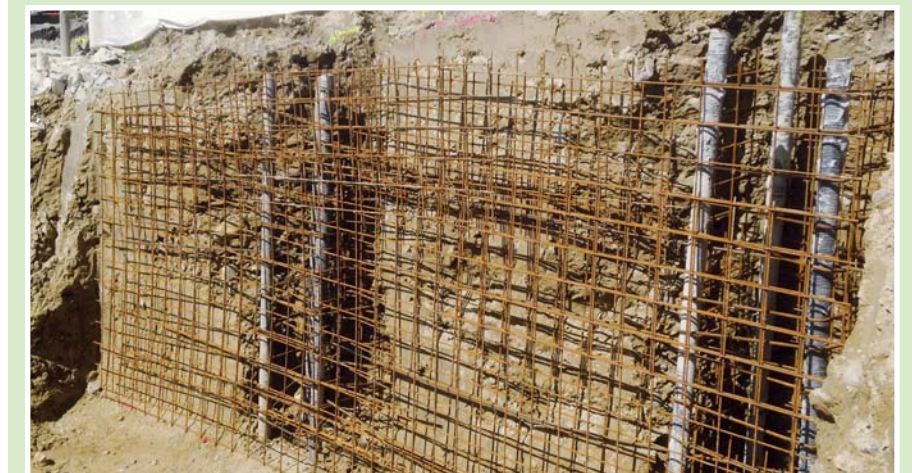
Die Mikropfähle werden nach dem Aushub mit Armierungsbögen zu Vierergruppen (MPS-Ständer) fixiert. Zwischen die Ständer werden Armierungsnetze eingelegt und mit Gunit (Spritzbeton) ausbetoniert.
