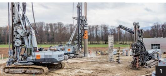
suchen durch den hauseigenen Geotechniker ermittelt und anschliessend durch die Entwicklung einer neuen, effizienteren Düse durch die F&E-Abteilung der GSTB realisiert. Um die Dichtigkeit der Sohle gewährleisten zu können, wurde der exakte Verlauf jeder der rund 400 Bohrungen mit einer Sonde vermessen.
