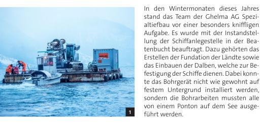
stand das Team der Ghelma AG Spezialtiefbau vor einer besonders kniffligen Aufgabe. Es wurde mit der Instandstellung der Schiffanlegestelle in der Beatenbucht beauftragt. Dazu gehörten das Erstellen der Fundation der Ländte sowie das Einbauen der Dalben, welche zur Befestigung der Schiffe dienen. Dabei konnte das Bohrgerät nicht wie gewohnt auf festem Untergrund installiert werden, sondern die Bohrarbeiten mussten alle von einem Ponton auf dem See ausgeführt werden.
