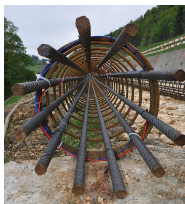
Abb. 1: Bewehrungskorb (Rot = Temperaturkabel PCF, Blau = Dehnungskabel V9)
